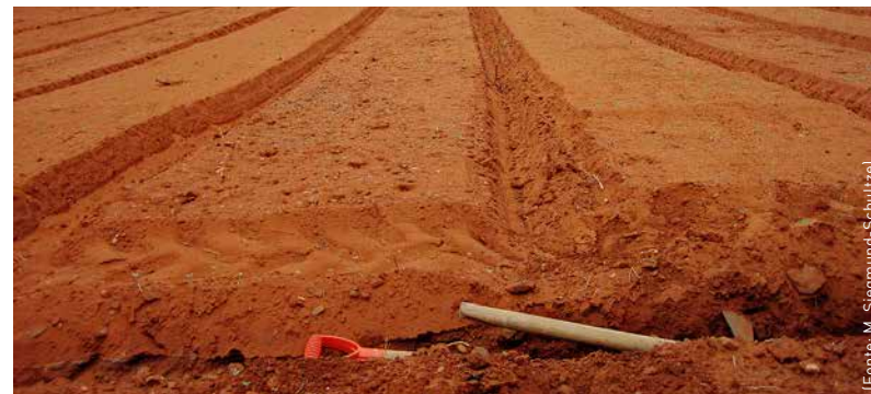
Instalação autofinanciada de infraestrutura de irrigação melhorada (gotejamento) em Icó-Mandantes.
